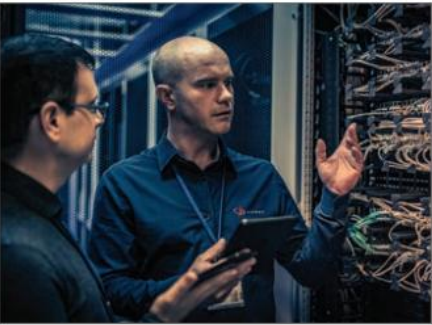
Auditorías de cableado del centro de datos
