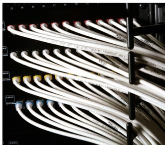
采用直径更小的线缆，可显著减少线缆束尺寸和通道填充率，从而节省空间
