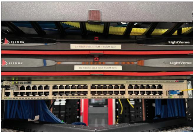
尼克劳斯儿童医院的100G 主干基础设施采用了西蒙 LightVerse® Pro 高密度光纤布线系统和西蒙 LC BladePatch® 光纤跳线进行连接。
