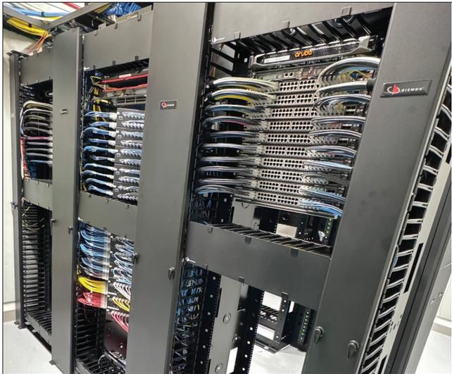
西蒙 UltraMAX™ 6A 类非屏蔽铜缆连接系统配备直径更小的三层（TL）非屏蔽线缆，为医院内各类设备提供可靠的 PoE 和 10G 传输性能。西蒙的 2 立柱 RS 系列机架搭配 RouteIT 垂直线缆管理器，以及直径更小的 SkinnyPatch® 6A 类非屏蔽模块化跳线，优化了线缆管理，改善了气流，并支持针对医院各类应用进行颜色编码。
