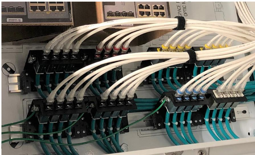
采用 DIN 导轨式安装的屏蔽布线来支持 PoE 应用。
